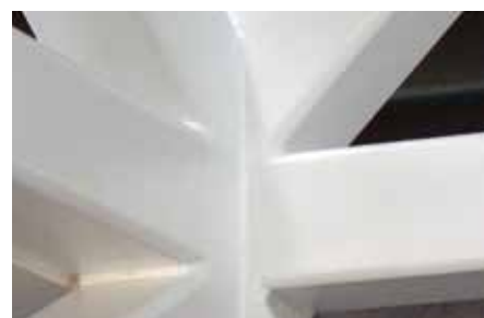
Lasverbindingen in uitvoering en na afwerking met een brandwerende coating.
