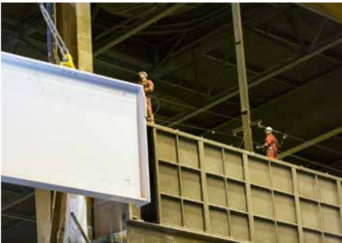
De kraanbaanliggers zijn 3,5 m hoog.
