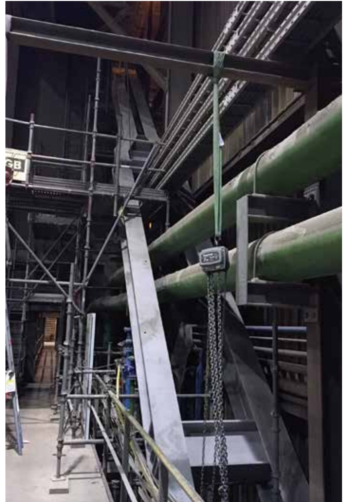
De drukdiagonaal is ook berekend op een bufferstootkracht van 2300 kN.
