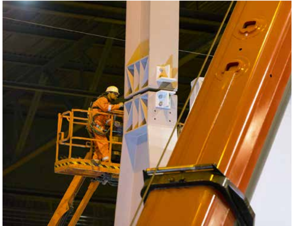
Montage opvangconstructie die daarna op spanning is gebracht met vijzels om dak op te vangen.
