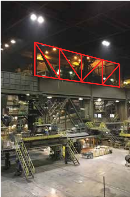
Alternatieve vakwerkconstructie (Machinehalzijde).
