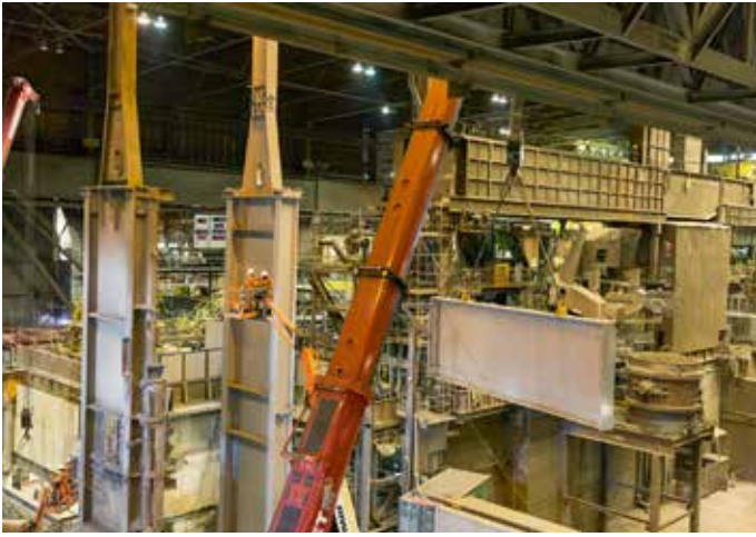
Montage (eerste deel) kraanbaan Giethal.
