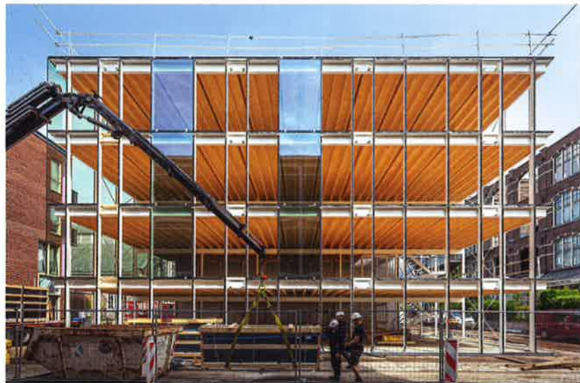
En haut de la page: Éléments de plancher préfabriqués.
