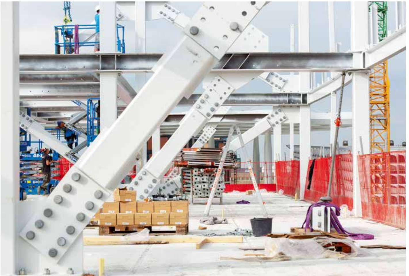
Er is gezorgd voor voldoende mogelijkheden tot het vormen van een tweede draagweg.
