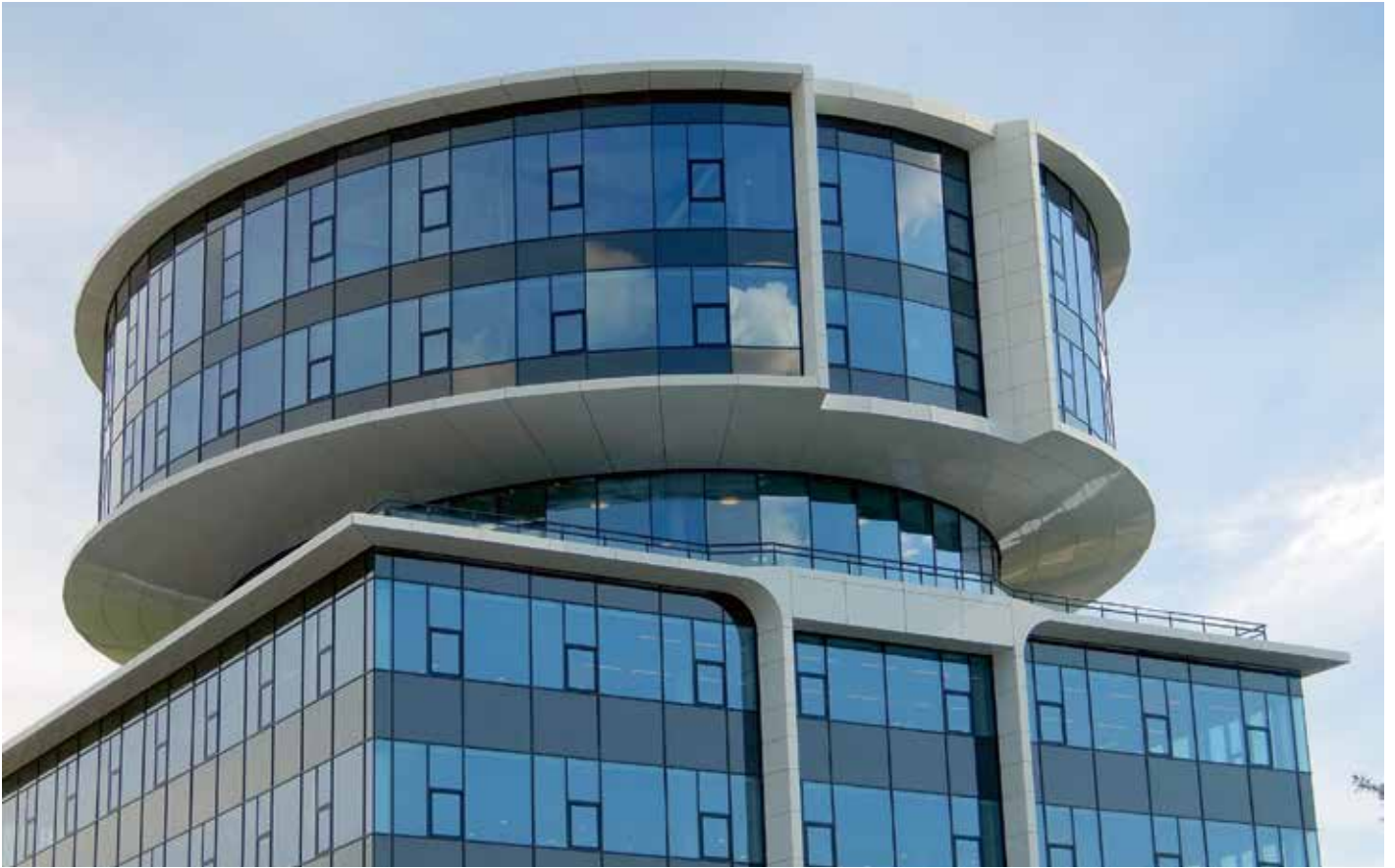
Het constructieve spanningsveld: de twee verschillende vormen onzichtbaar in elkaar over te laten gaan.
