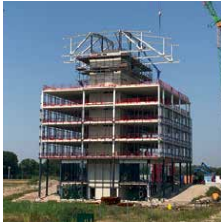
Spanten in twee richtingen doorgaand uitgevoerd.
