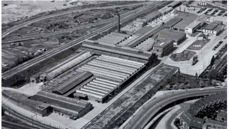
In 1960 nam de RET de remise aan de Kleiweg over van spoorfabrikant Allan.
