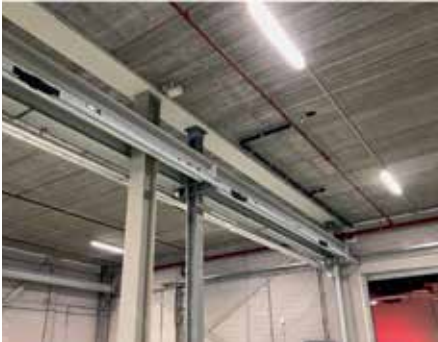
Ontkoppeling kraanbaan-kantoorconstructie (2).
