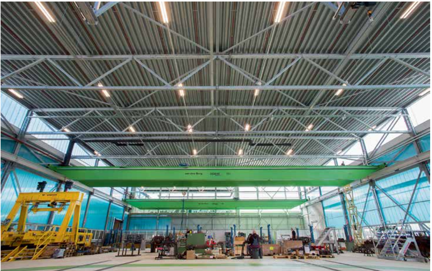
Draaistellenhal met kraanbaan van 36 m lang.
