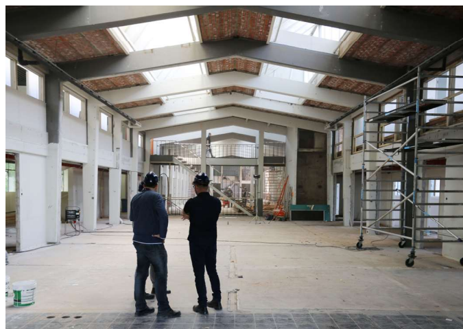
▲ MIDDENDEEL VAN GEBOUW A VLAK VOOR HET OPENBREKEN
