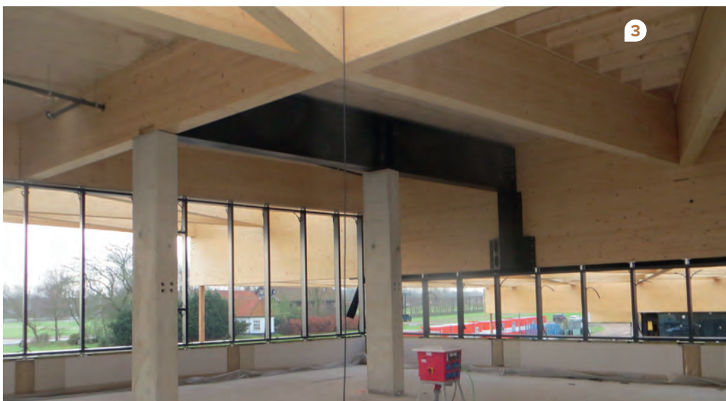
1 // De opbouw van het glasdak, met goten tussen de diverse driehoekige elementen. (Foto: Brakel Atmos) 2 // In het restaurant wisselen open en dichte delen elkaar af binnen de driehoekige houtstructuur. 3 // IMd voegde staalprofielen toe als drager van de dubbelhoge gelamineerde ligger, die op zijn beurt het hele dak boven de entree draagt. (Foto: Frans de Brabander)
