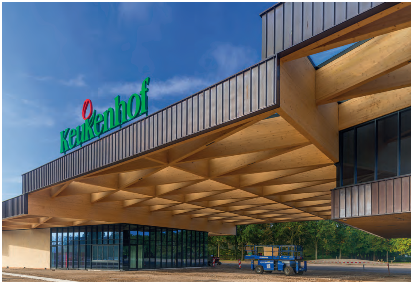
De dubbelhoge gelamineerde liggers langs de kopgevels dragen het kolomloze dak boven de eigenlijke entree.
