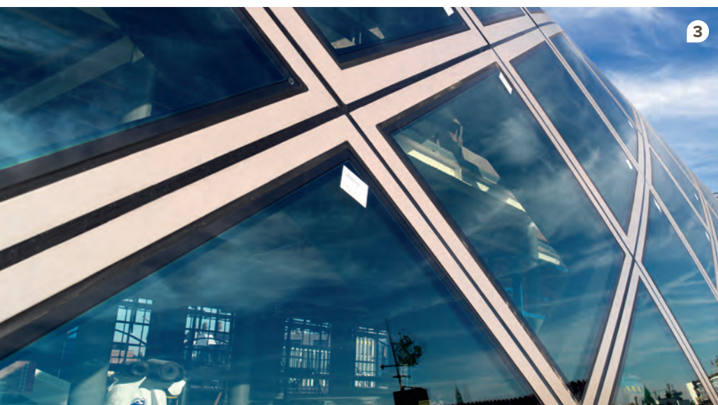
1 // De staalconstructie is in grote segmenten geprefabriceerd. De segmenten zijn onderling verbonden met bouten. 2 // De knikken in de staalconstructie en het verloop in de extrusieprofielen zijn in deze zichthoek duidelijk te zien. 3 // De voeg tussen de warmgebogen ruiten en de cassettes is met structurele kit afgedicht; ook de aansluiting van de cassettes onderling is structureel gekit.
