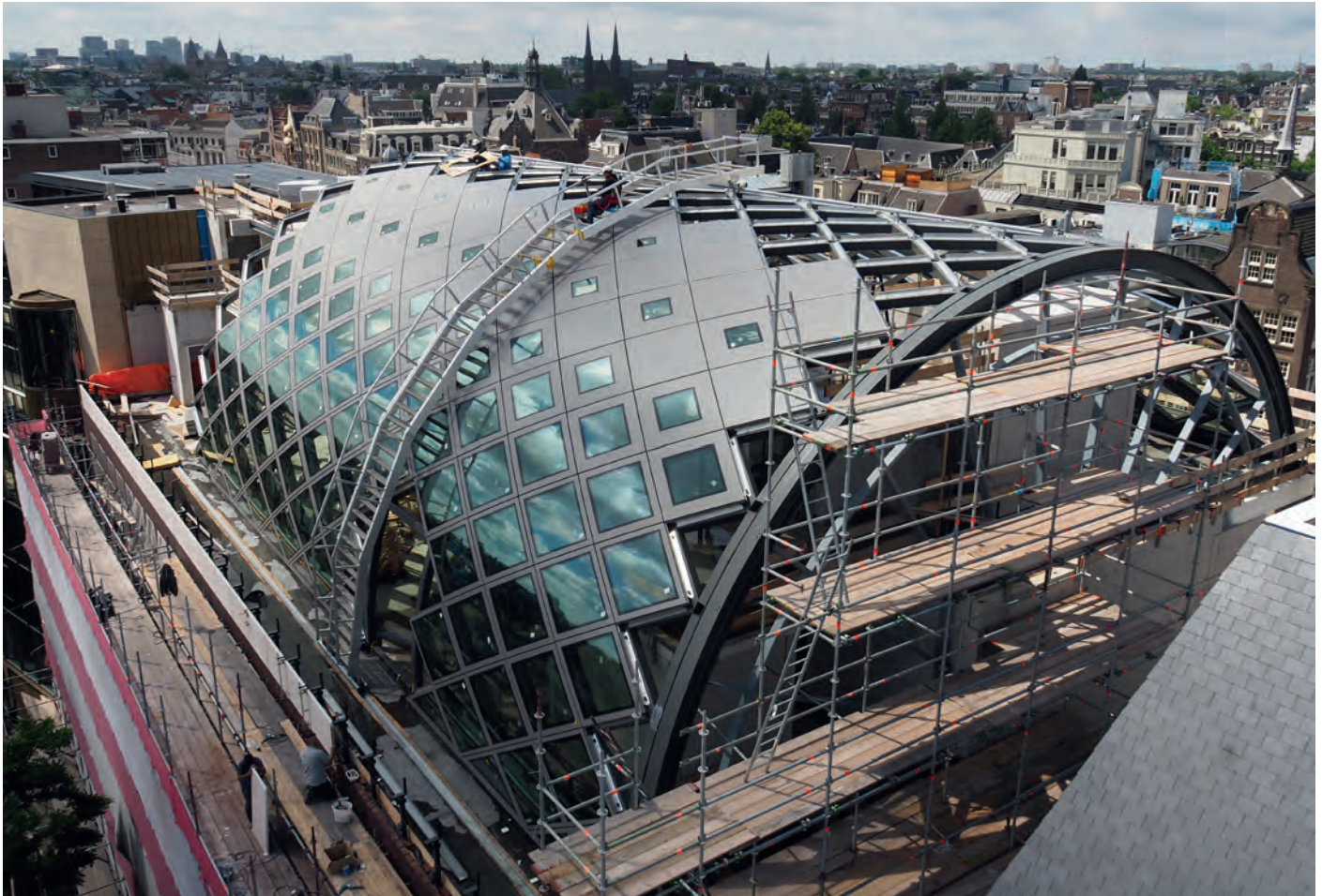
De cassettes zijn gemonteerd vanaf een speciaal ontwikkelde aluminium brug. (Foto: Ivy Group)
