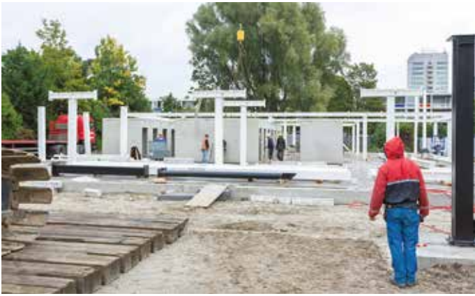
Alle constructie-onderdelen worden aan de onderzijde en kopse kanten gedocumenteerd en digitaal vastgelegd.
