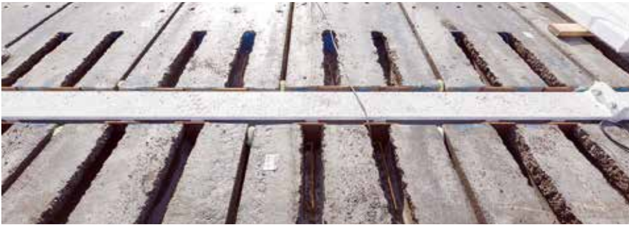
Cruciaal: demontabele verbinding vloer-ligger.
