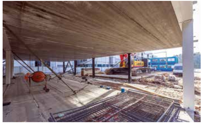
Ook eventuele afwijkingen in de uitvoering worden gedocumenteerd om niet bij demontage tegen verrassingen aan te lopen.
