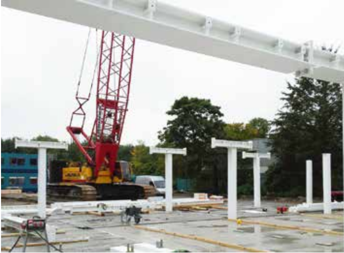
Momentvast T-stuk waartussen de liggerdelen worden gemonteerd.
