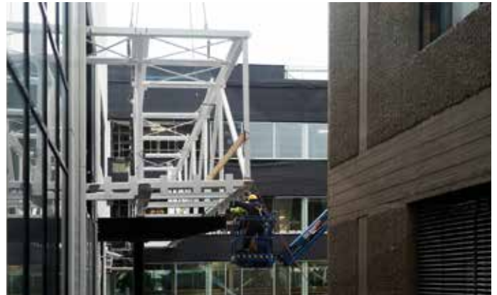
De luchtbrug wordt in drie delen geprefabriceerd aangeleverd, op locatie samengesteld en in zijn geheel ingehesen.
