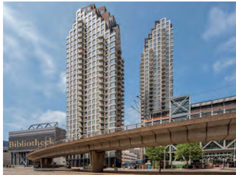
Het project ligt ingeklemd tussen het Prins Bernardviaduct, de trambaan, de Koninklijke Bibliotheek en de Utrechtsebaan. (Foto: Emmely van Mierlo)
