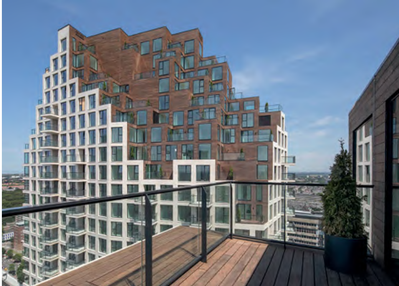
De kroon kreeg een extra accent, zowel in kleur als in materiaal. Voor de terrasvloeren en de gevels is gekozen voor een duurzame bamboecomposiet. (Foto: Daria Scagliola)
