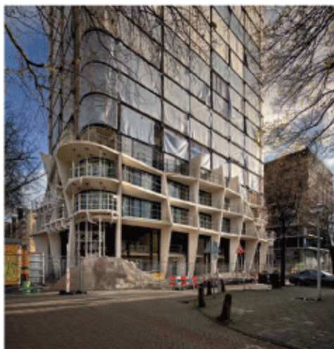
De prefab gevelelementen zijn aan de gevel gehangen nadat de gevelruimten zijn aangebracht.
