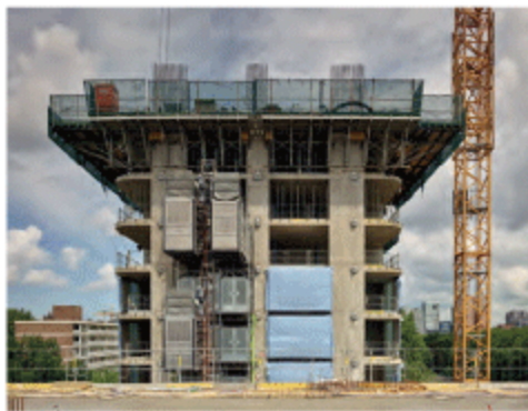
De stalen consoles waar de vinnen aan zijn opgehangen zijn met de vloeren meegestort.
