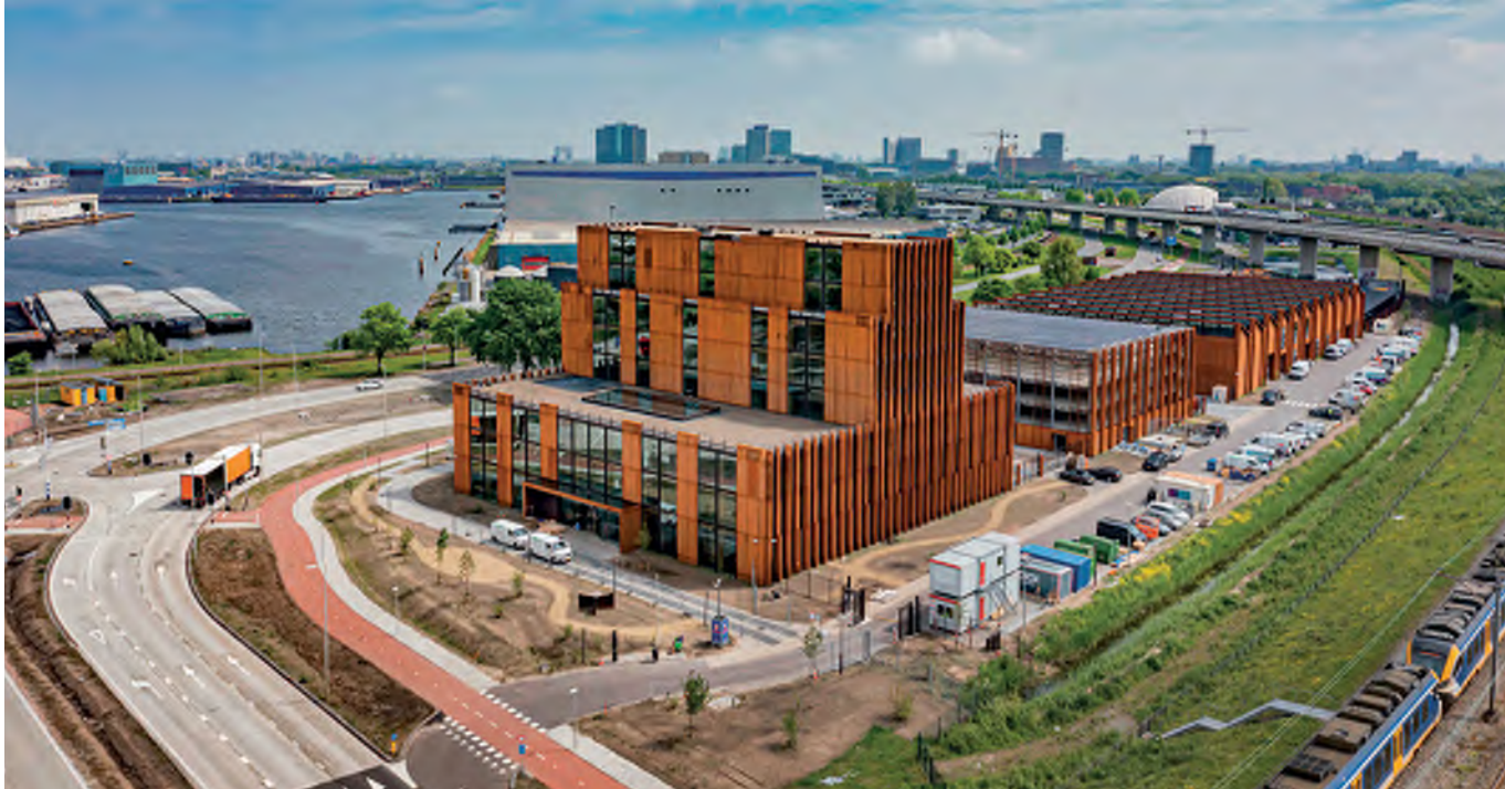
Het plot is langgerekt, gekozen werd voor het achter elkaar plaatsen van functies met in het midden de parkeergarage. Alleen het kantoorgebouw is van hout.
