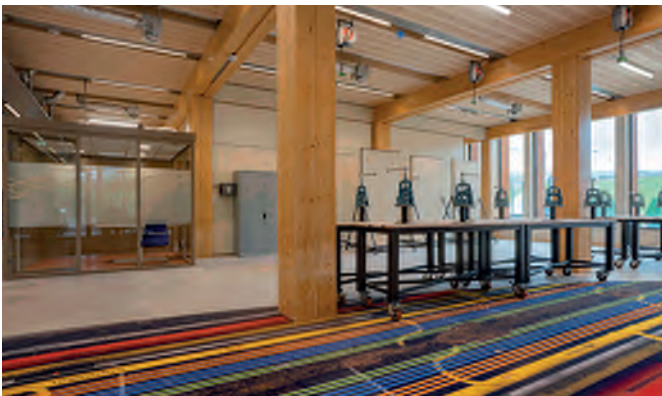
Op de begane grond is een opleidingsruimte waar volop met installaties en kabels gewerkt kan worden.
