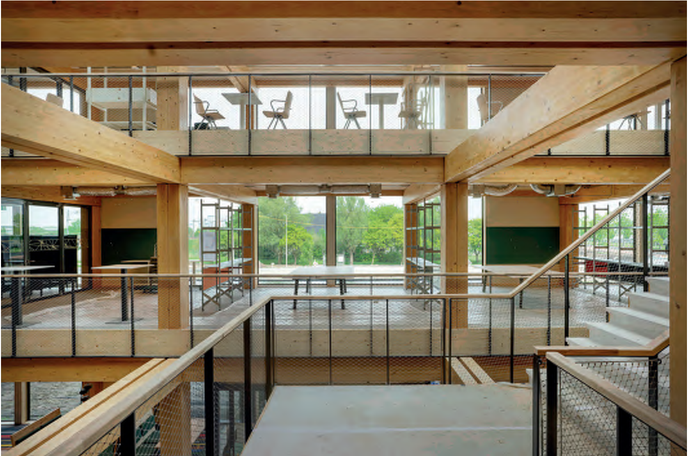
Over de centrale trap in het atrium kunnen alle medewerkers van de acht verdiepingen elkaar tegenkomen. Er is veel transparantie. Het grid van 5,4 bij 5,1 meter maakt tal van indelingen en functies mogelijk.
