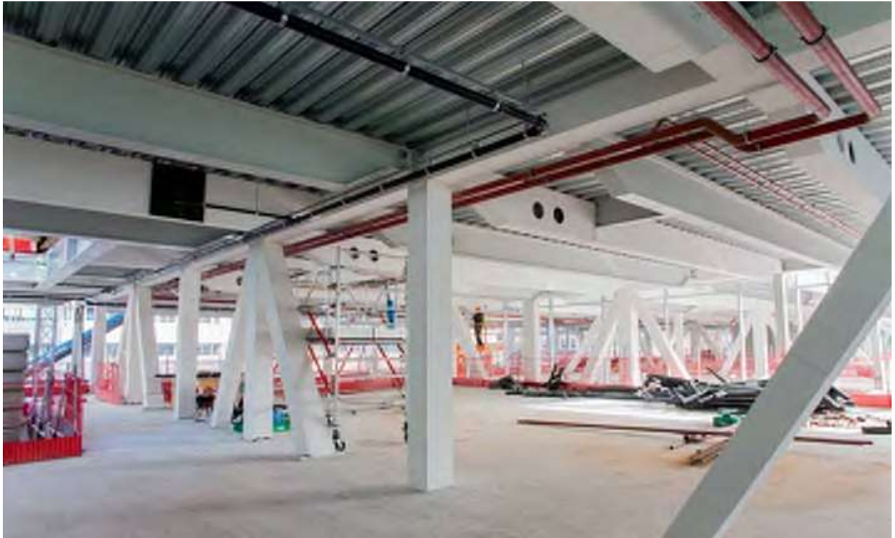
Figuur 9. De helft van de vloerdragende liggers had geen brandwerende bekleding nodig.
