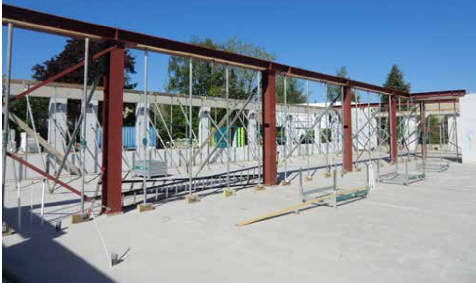
De Avenir in Eindhoven, hergebruikt staal (donorskelet) is toegepast bij de realisatie van de school – Foto IMd Raadgevende Ingenieurs
