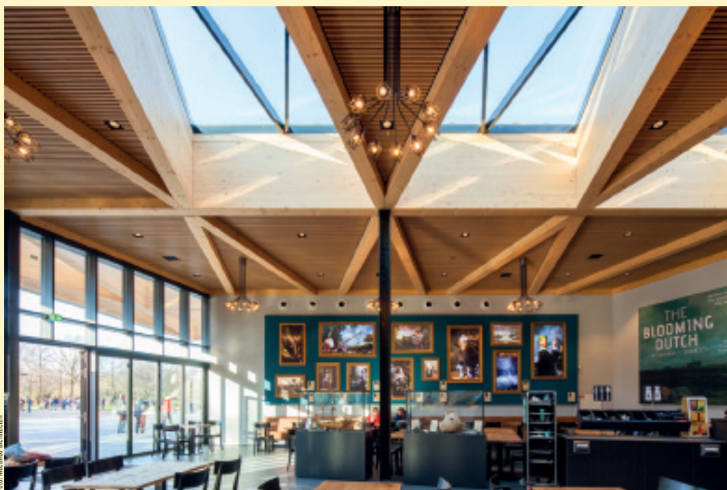
Il ristorante, nell'edificio a un piano. Al centro è ben visibile una delle colonne in acciaio, così come rimane visibile, anche se non vetrato, il pattern triangolare della copertura.
