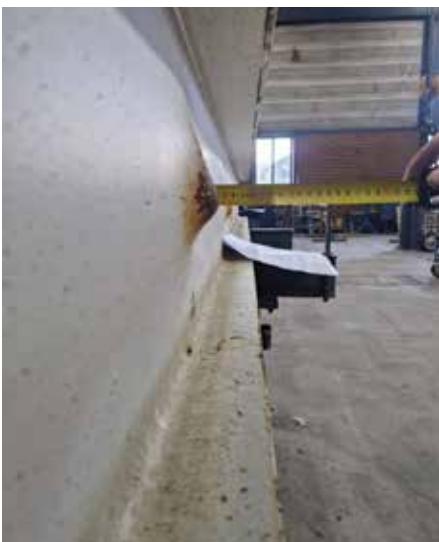
11. Vierde controle bij het staalconstructiebedrijf.
