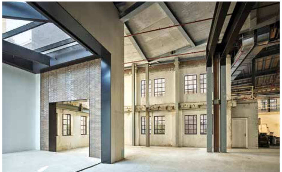
Aanzicht oorspronkelijke gevel met aanvullende staalconstructie voor sloop verdiepingvloer met doorgang van Pershal (rechts) naar wintertuin (links).
