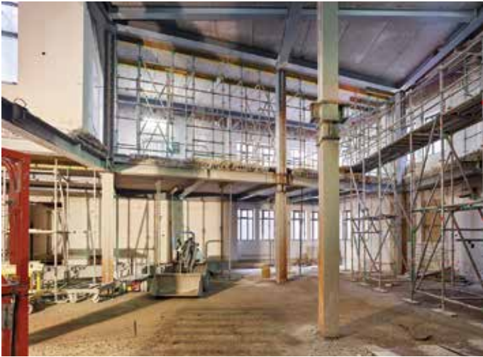
Vloer verwijderd. Blijvende kolommen zijn versterkt met UNP's (detail 8, p. 33).
