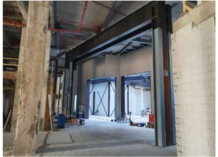
Situatie na sloop van de bewuste kolom met de nieuwe staalconstructie.
