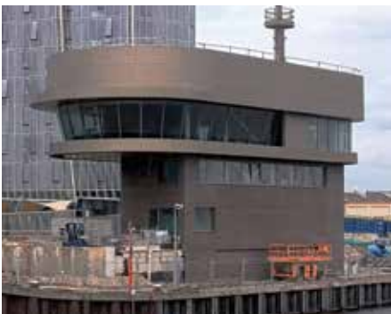
8. Metalen gevelbekleding (foto: Besix).
