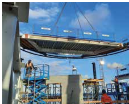
9. Prefab vloerconstructie (foto: Buiting Staalbouw).
