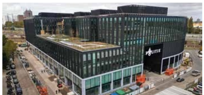
10. Daktuin kan worden getransformeerd naar een kantoortent.
