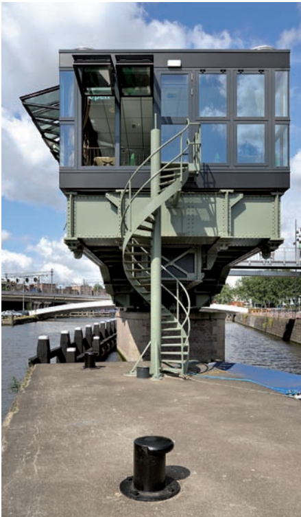
'Achtergevel' met noodtrap.
