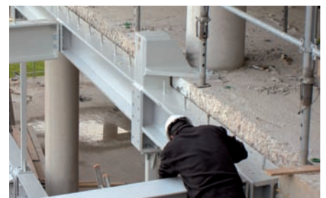
Aansluiting staal op beton.
