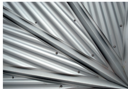
De aluminium gevelbekleding is met de punten mee gemonteerd.
