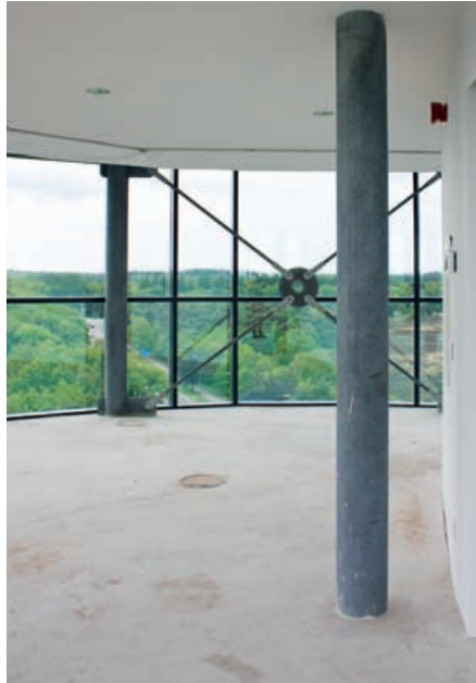
1 e verdieping 'nieuwbouw'.
