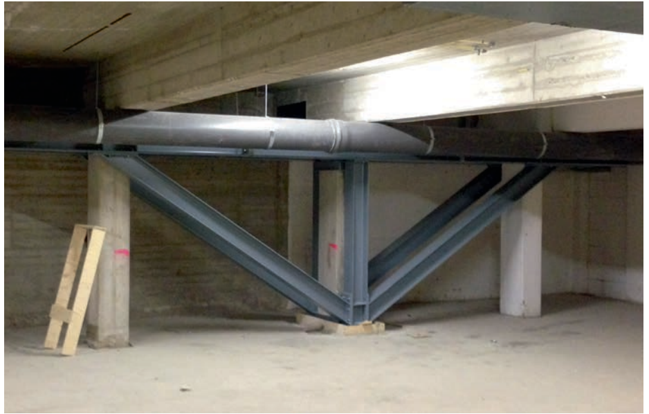
2. Deze schoorconstructies voorkomen aanpassingen aan de fundering.
