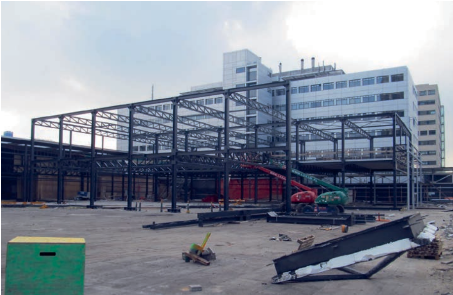
6. Tweelaagse nieuwbouw op de bestaande parkeergarage.
