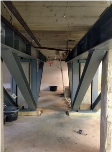
1. Twee constructies per kelderkolom.
