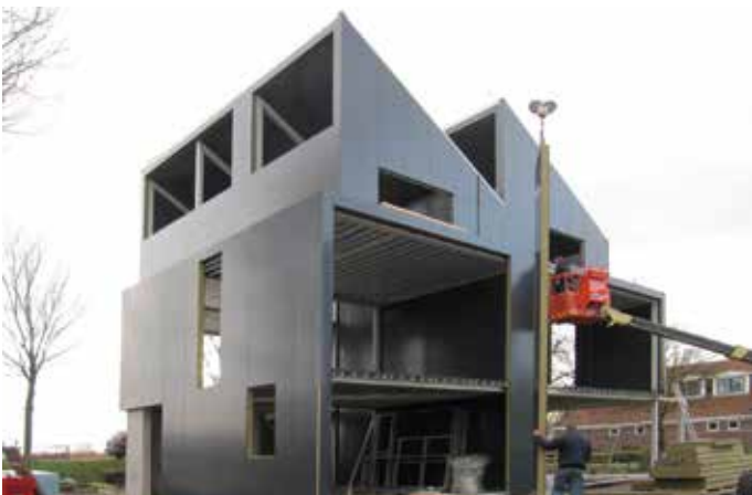
De sandwichpanelen, die in hun vlak stijf zijn, dragen niet bij aan de stabiliteit.
