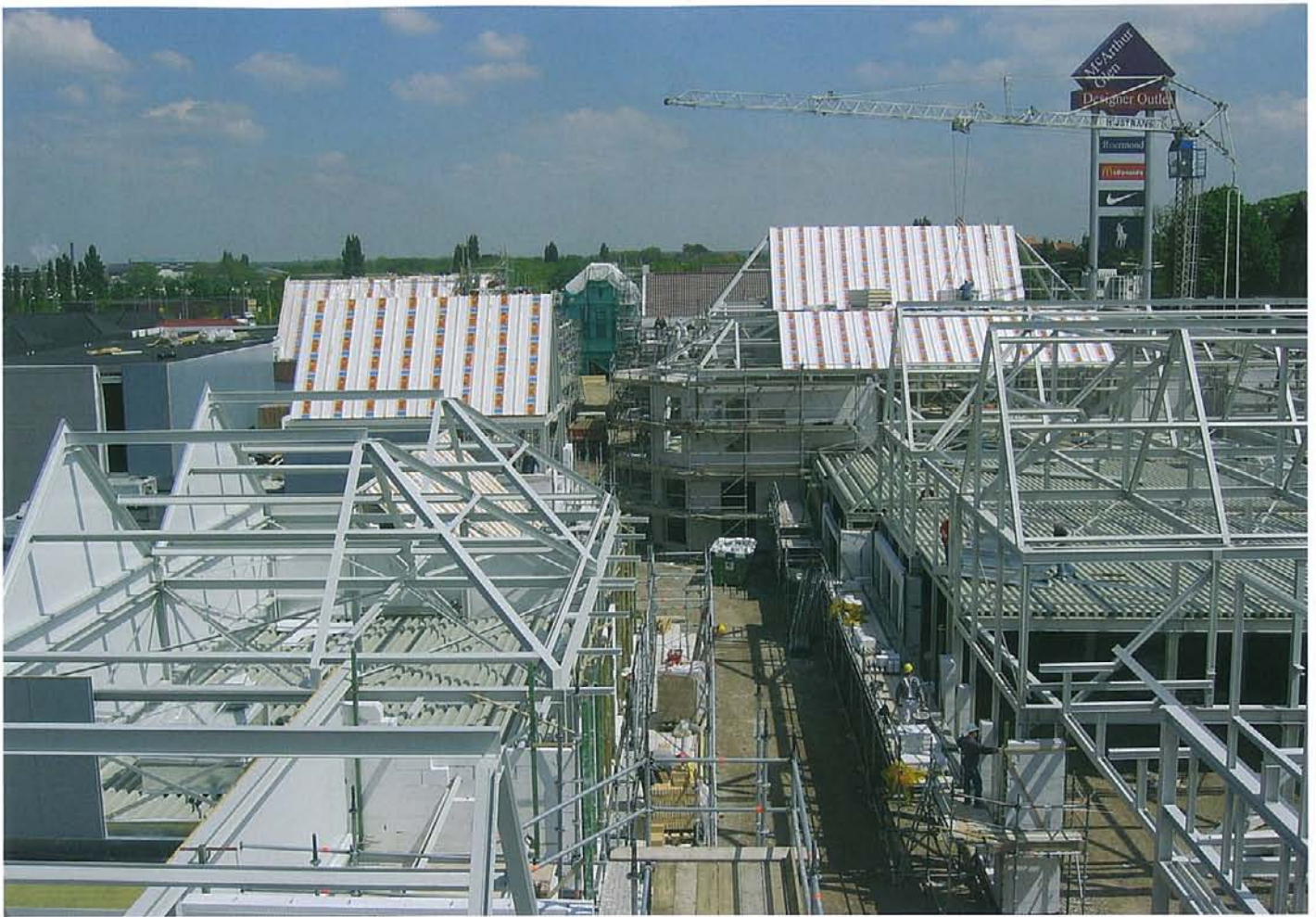
Overzicht staalconstructie. Sommige gebouwen krijgen op de verdiepingen een geprofileerde stalen dakplaat. Deze kunnen na verloop van tijd worden veranderd in staalplaat-betonvloeren voor opslag.
