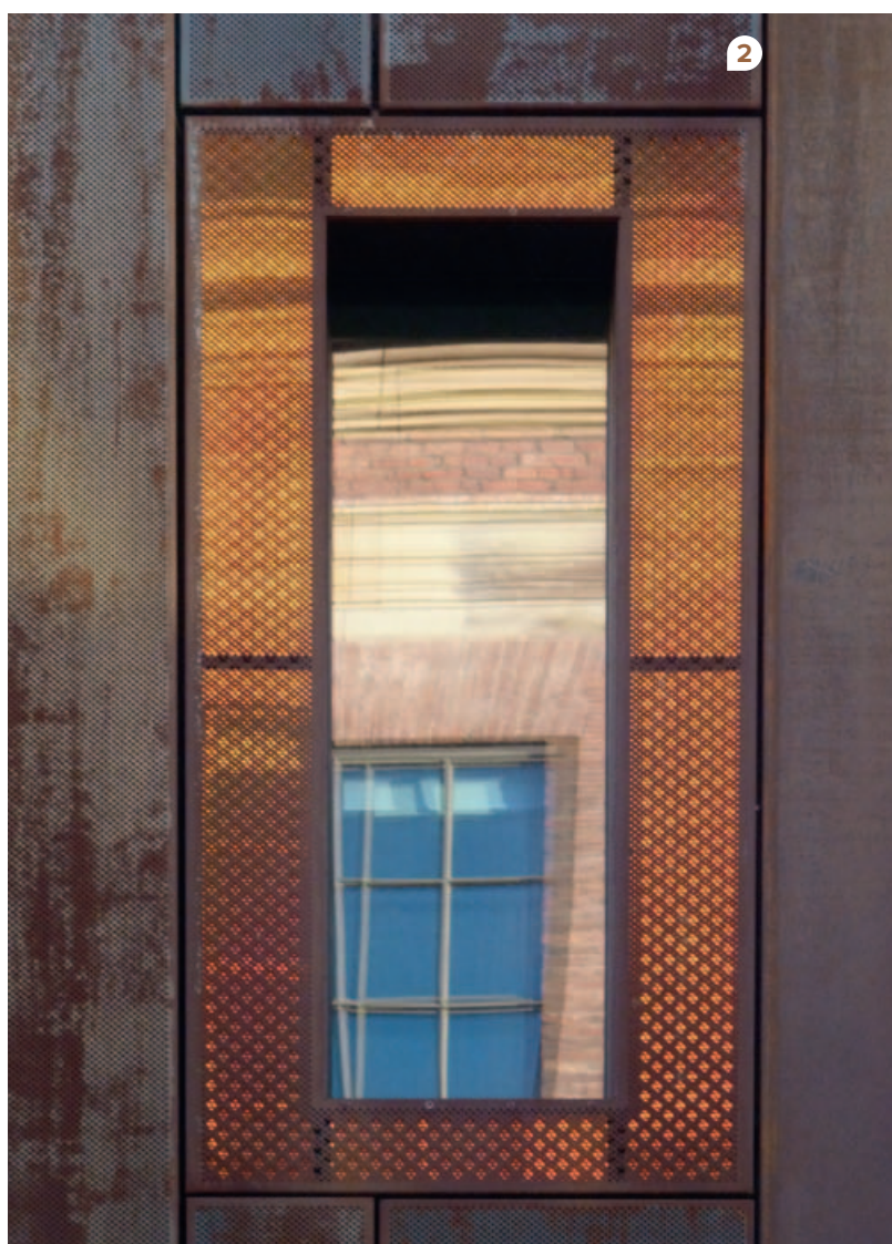
1 // Goed verborgen in de weervast stalen gevel is een segmentdeur voor de inrit naar de inpandige expeditieruimte gemaakt. 2 // De weervast stalen bekleding is in de vorm van cassettes op de gevel gemonteerd en is op diverse plaatsen geperforeerd. Achter het geperforeerde raamkader is een iriserende folie aangebracht.
