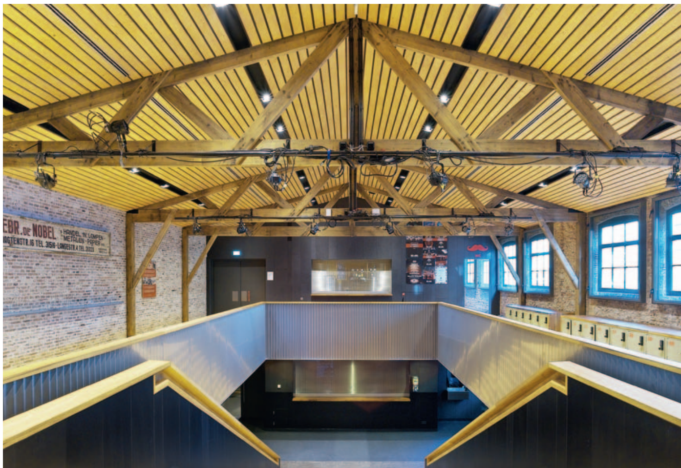
De eerste verdieping van de foyer in de voormalige fabriek met de teruggeplaatste houten dakspanten. Boven het plafond in de dakspouw bevinden zich de installatievoorzieningen.
