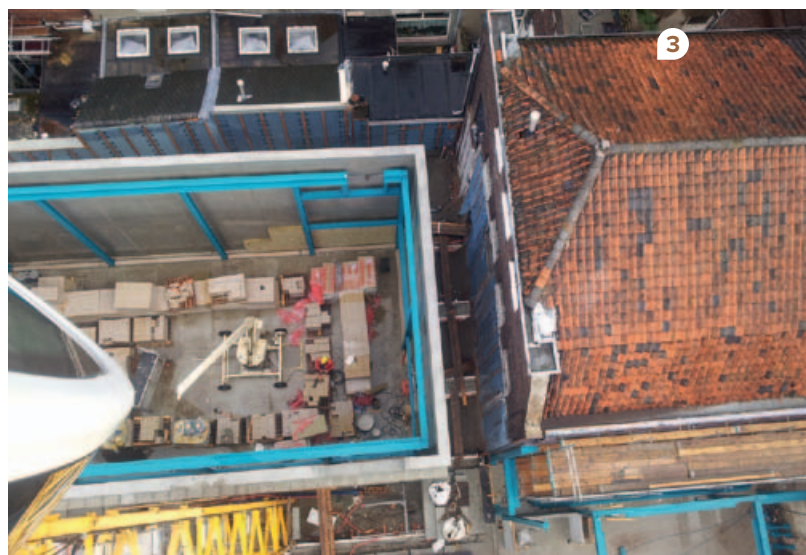
1 // Midden in een historisch bouwblok in de binnenstad van Leiden is het nieuwe poppodium Gebr. de Nobel gebouwd. 2 // Zicht op de staalconstructie van de foyer in de oude fabriek. De originele houten spanten zijn later onder de stalen spanten geplaatst. (Foto: IMd) 3 // De bouw van de kleine zaal met de doos-in-doostructie tussen de historische panden. (Foto: IMd)
