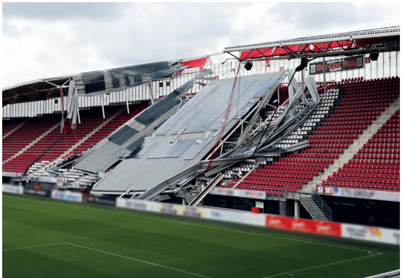
Een deel van het tribunedak in het stadion van AZ stortte in 2019 in. NTA 8790 moet zulke incidenten in de toekomst voorkomen (foto: Onderzoeksraad voor Veiligheid).
