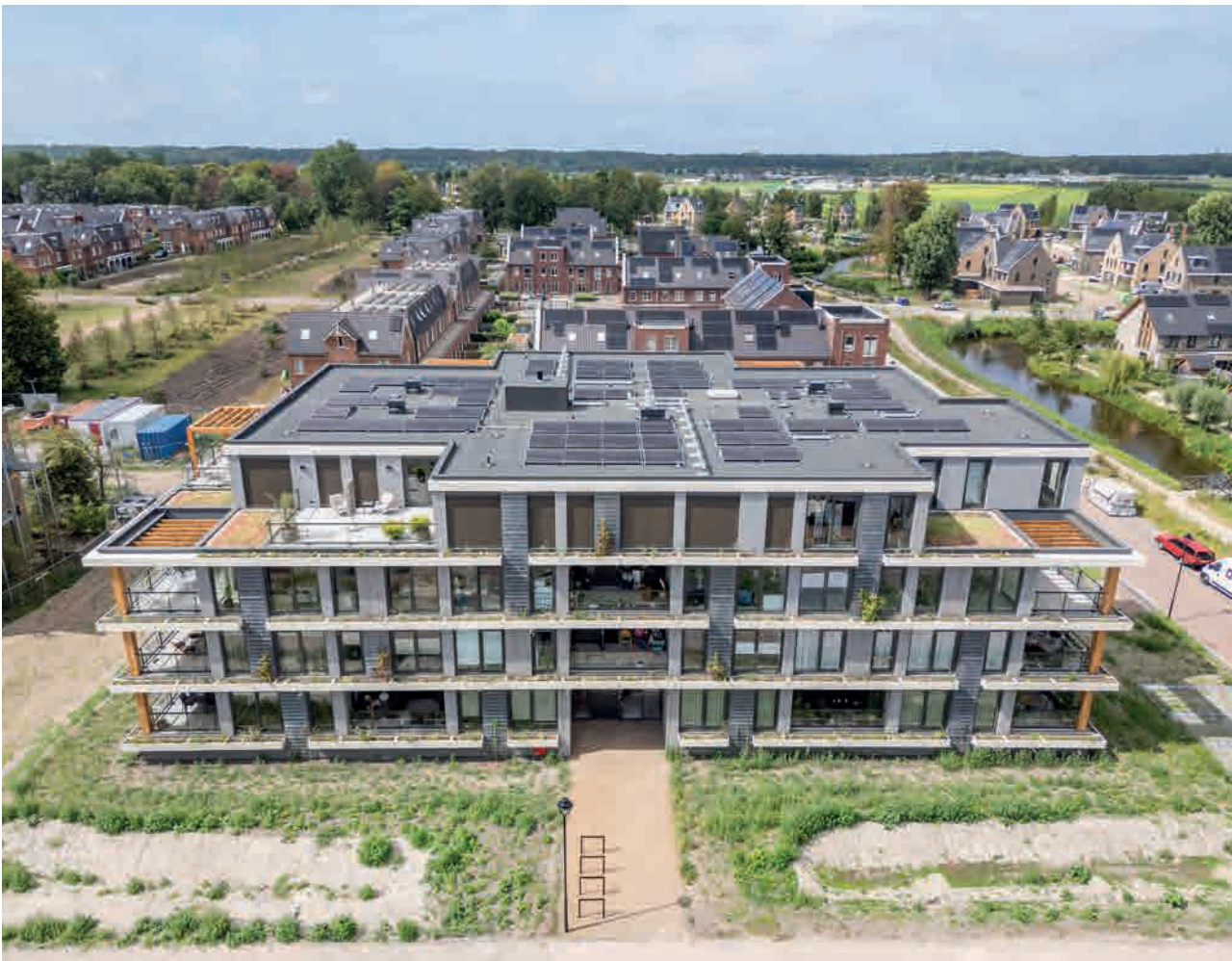
De appartementen op de bovenste verdiepingen liggen deels terug, waardoor ruimte voor daktuinen en terrassen ontstaat (foto: Bas Gijselhart, Base Photography).
