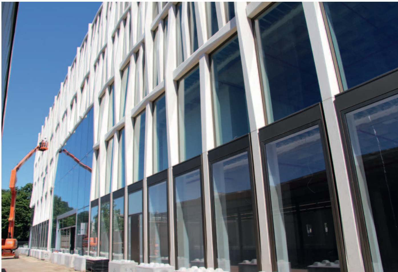
Op de begane grond vormen aluminium kaders een soort etalages. De entrees worden geaccentueerd door grote glaspartijen.
