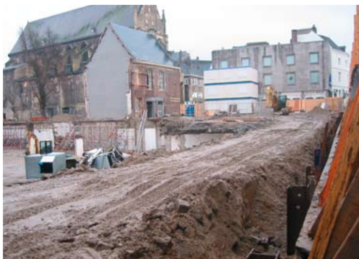
7 | Pico Bello aan de rand van de bouwput
