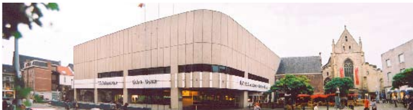
7 | Situatie voor sloop met aan de rechterkant het pand Pico Bello
