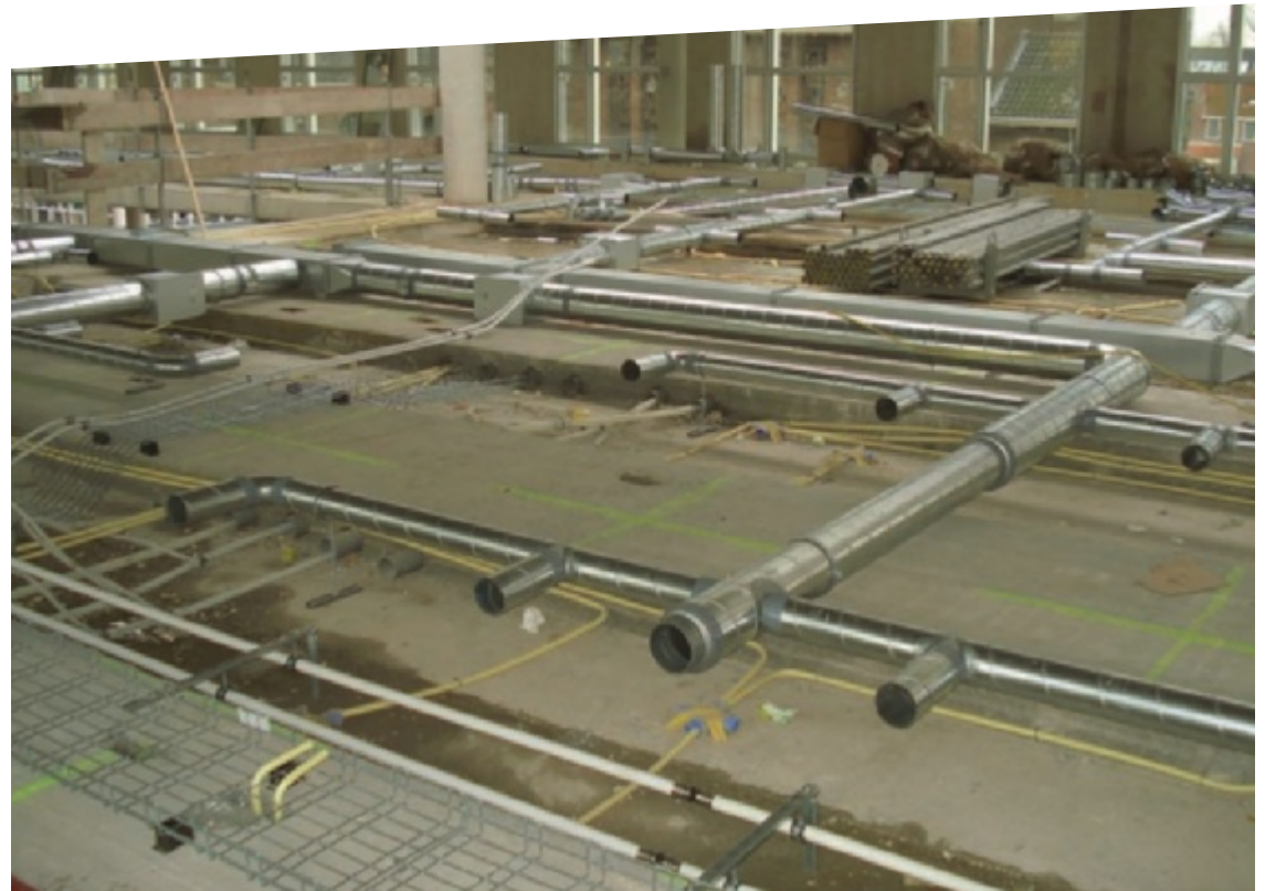
Gemeentehuis Zwijndrecht: integratie constructie met installaties
