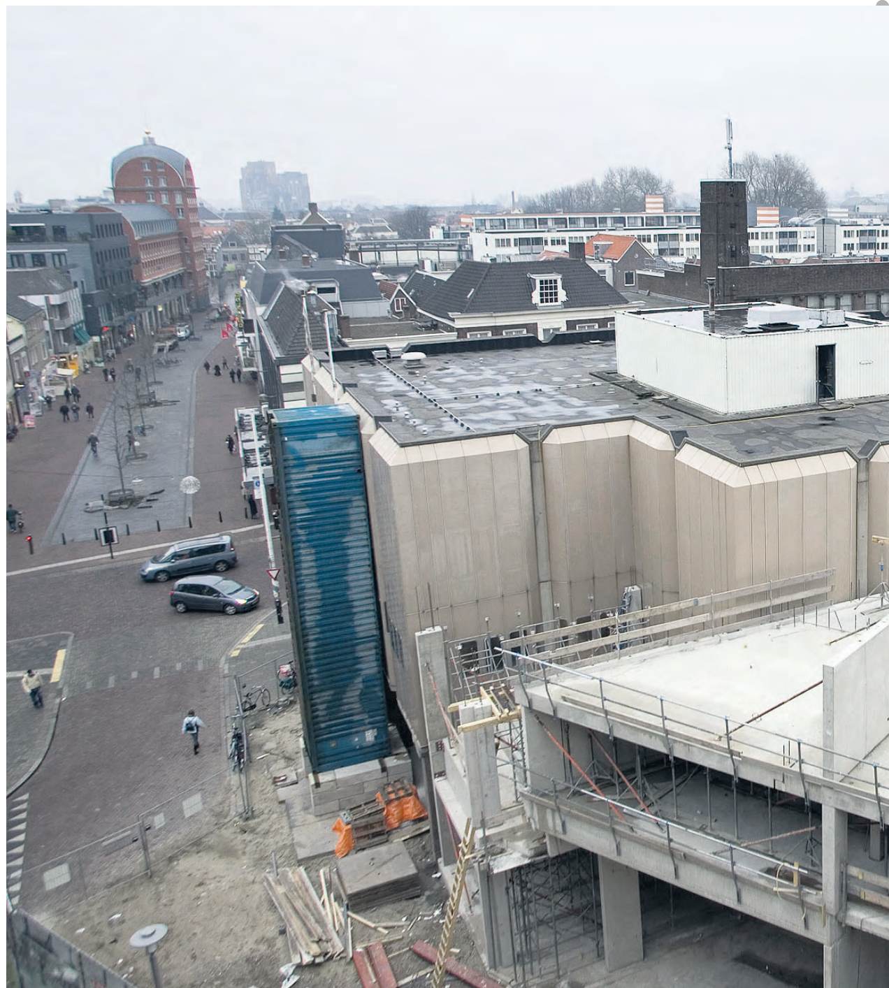
Bij het plan Bagijnhof Achterom in Dordrecht wordt de bovenste opslagverdieping van de Hema gesloopt en vervangen door twee
