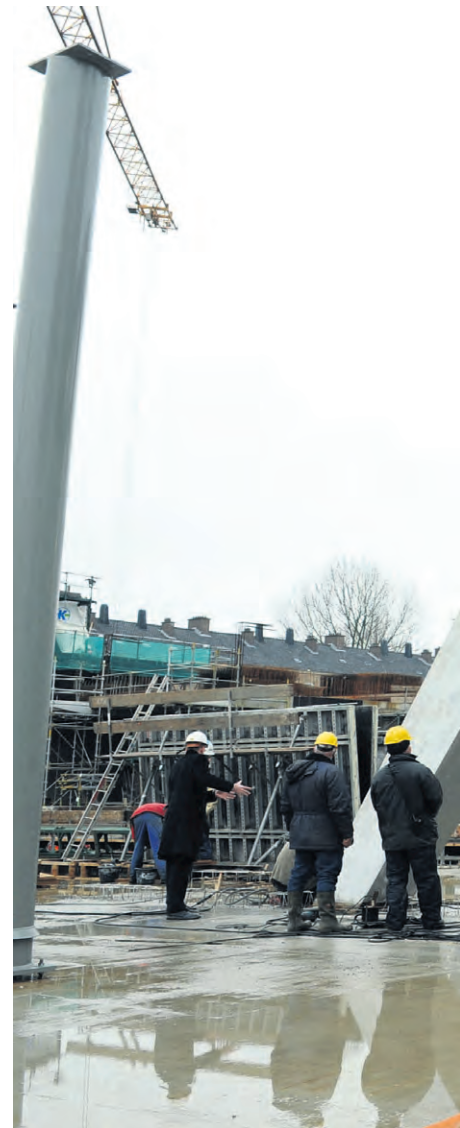
De draagconstructie voor de kerk wordt door staalbouwbedrijf Smulders met vijzels op zijn plek geduwd. Foto Dijkstra
