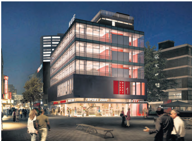
Het HUF-pand behield zijn kenmerkende glasgevel.
