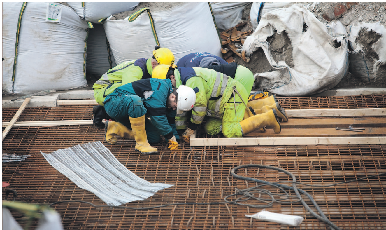
Soms moet er even kracht worden gezet om de extreem zware wapening aan te brengen voor de verzwaarde vloer van de oude kelder. Foto: Suzanne van de Kerk
