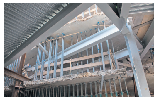
De nieuwe slanke staalplaatbetonvloeren verspringen ten opzichte van de oude vloeren. Foto's: Ronald Bakker
