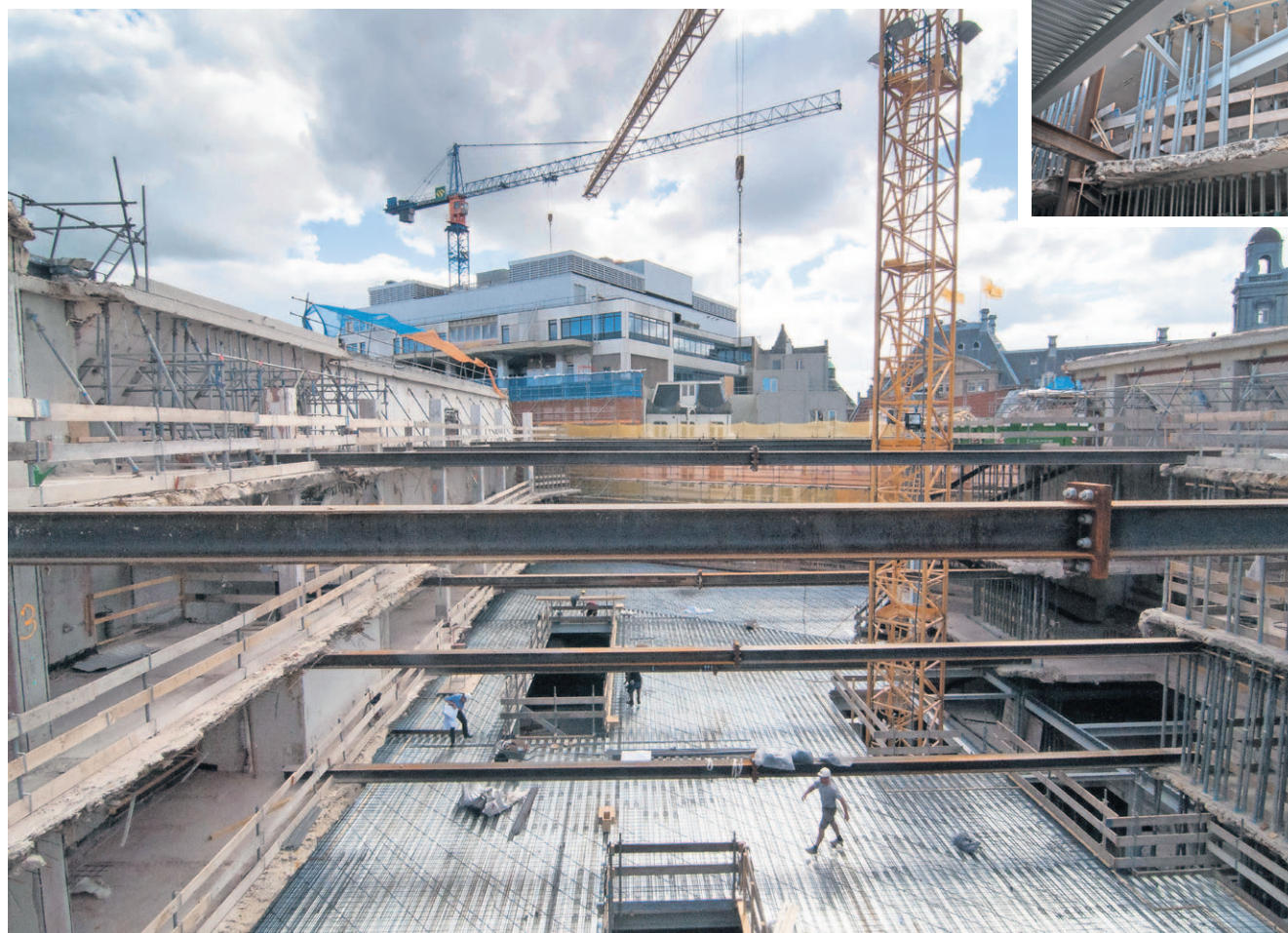
De nieuwe slanke staalplaatbetonvloeren verspringen ten opzichte van de oude vloeren. Foto's: Ronald Bakker
