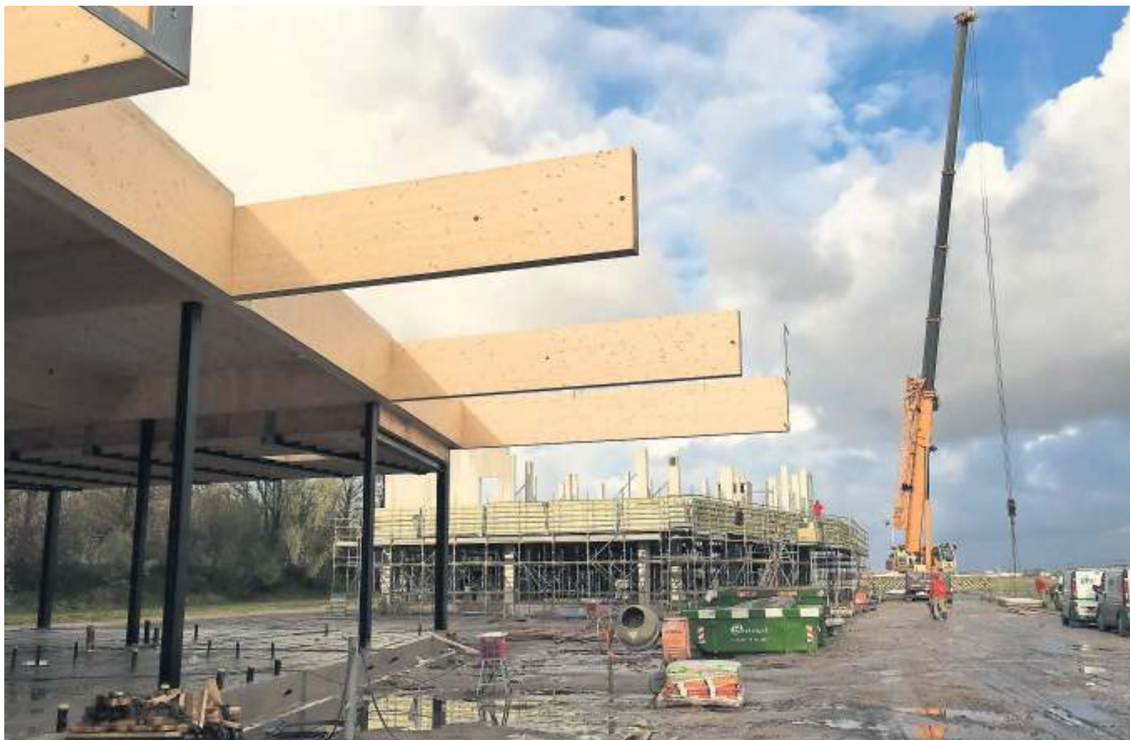
In het entreegebouw speelt de constructie – en dan vooral die van het dak – een beeldbepalende rol.
