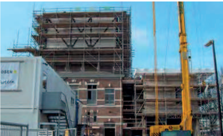
Toneeltoren in aanbouw - IMd
