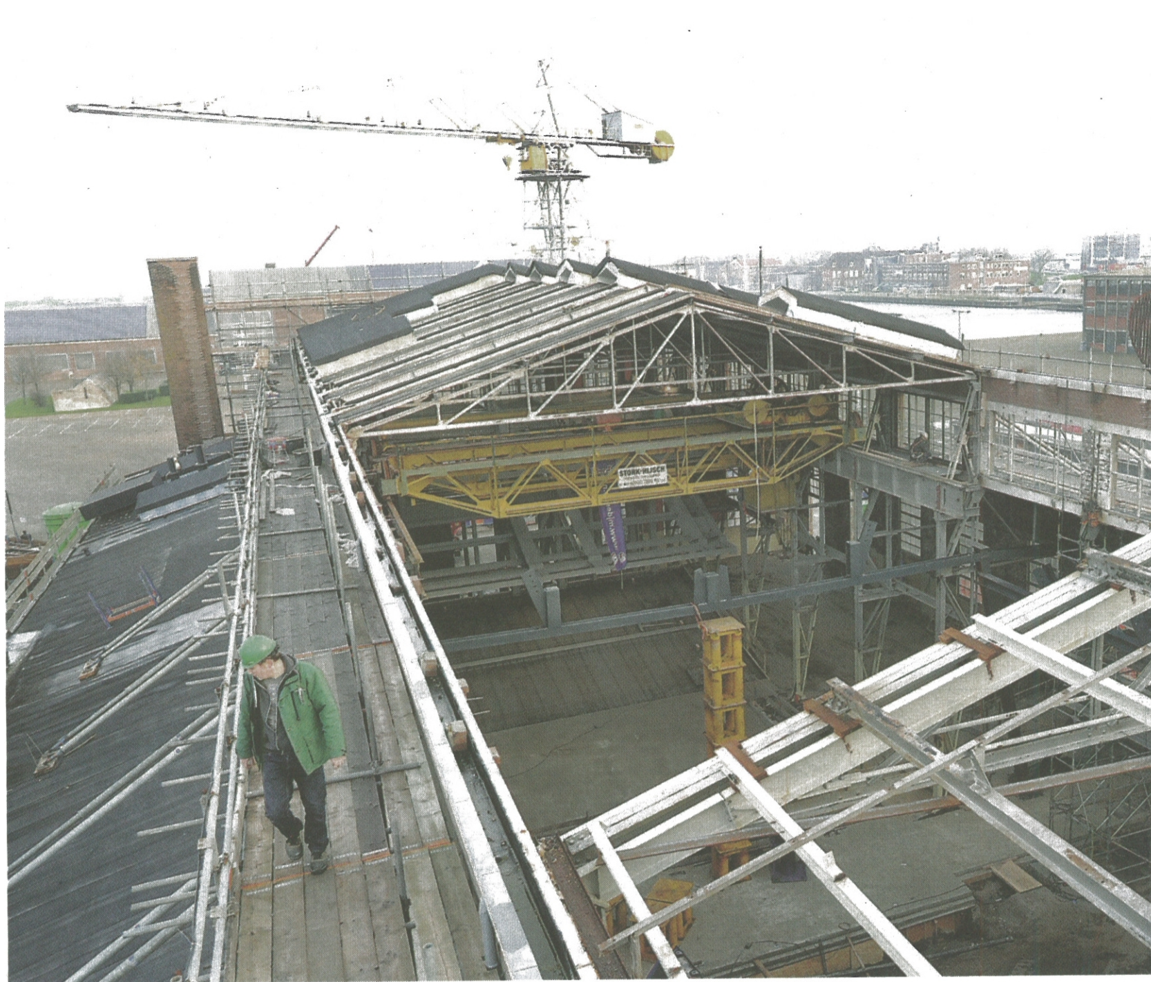
Het dak van de oude ketelmakerij ligt open om ruimte te bieden aan de nieuwe toneeltoren van. Achterin is nog een deel van de balkonconstructie te zien.
