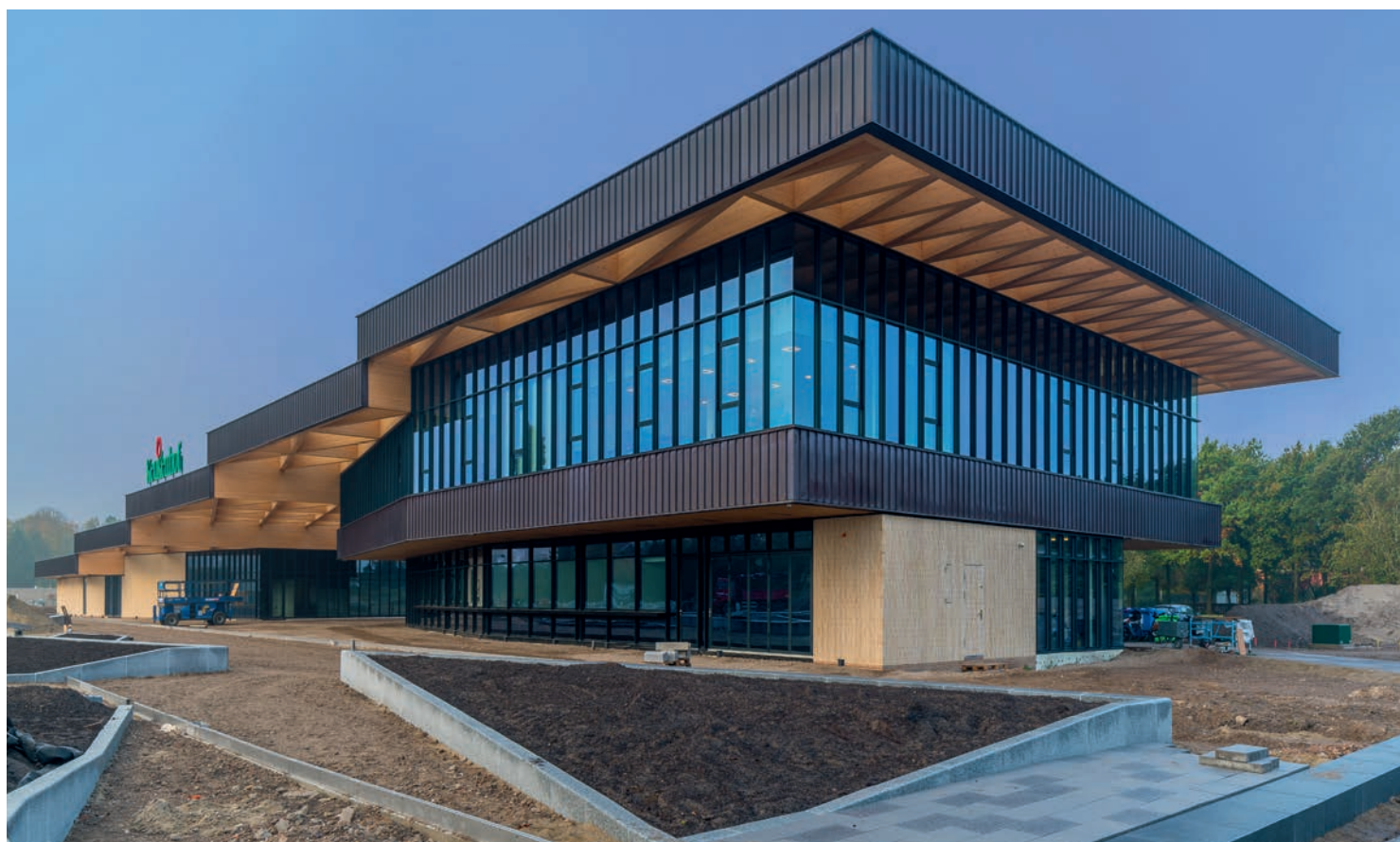
Het cascadedak is opgebouwd uit vijf treden met een breedte van 21,6 m en een totale hoogtesprong van 1,6 m.
