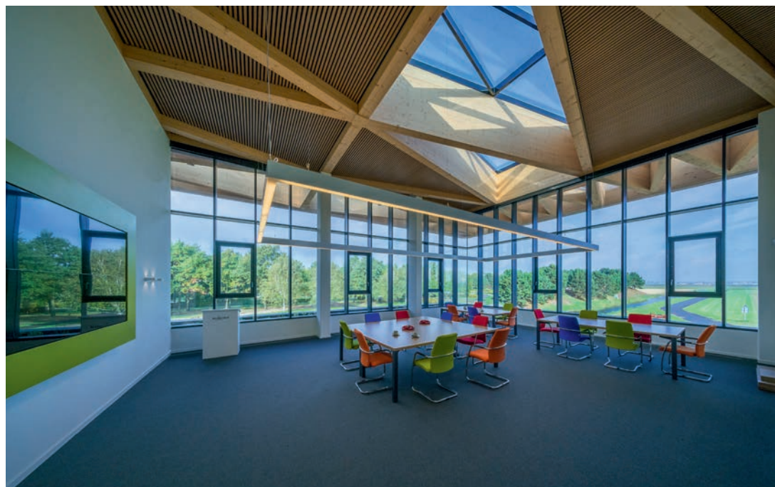
De algehele transparantie van de dakconstructie wordt binnen versterkt door daklichten.
