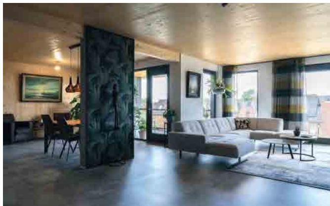
In de plafonds en veel wanden is CLT in het zicht gebleven.
