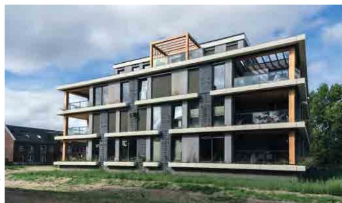
De buitengevel is afgewerkt met voorvergrijsd fraké. Verticaal tussen de woningen zitten rekken voor klimplanten.
