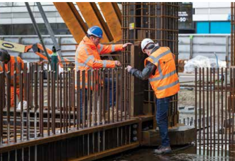
6. Plaatsing HD-profiel over stekken onderbouw.
