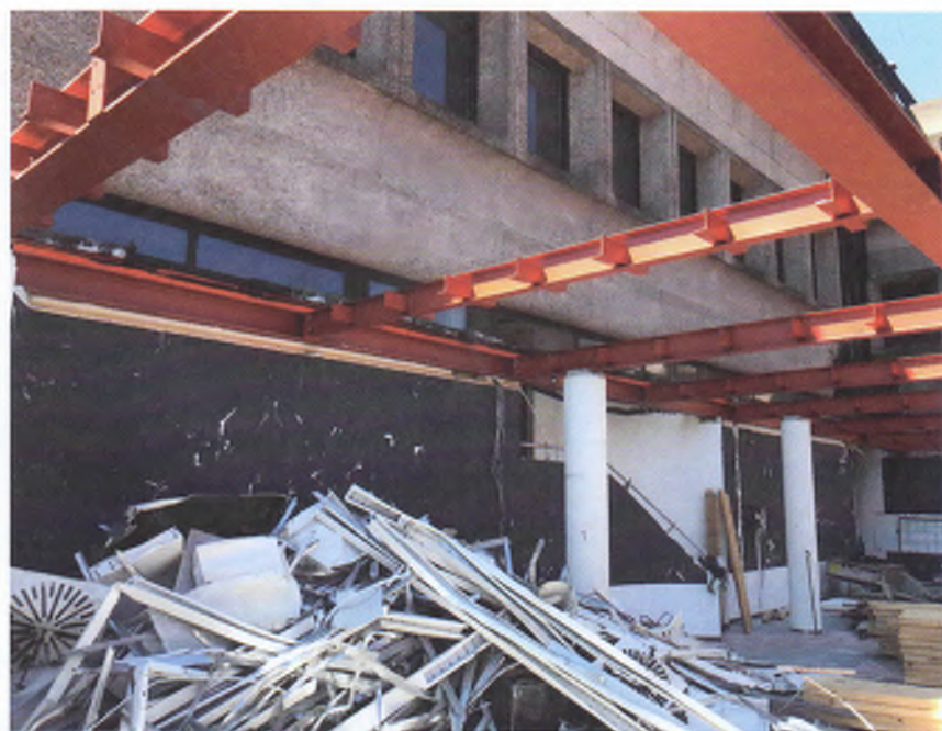
Boven: profielen uit donorgebouwen worden hergebruikt voor de sportaccommodatie (foto: IMd Raadgevende Ingenieurs).
