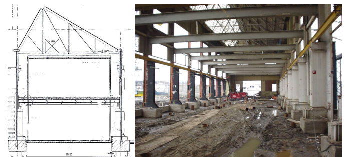
BESTAANDE STAAL LIGGERS HEBBEN EEN TWEEDE LEVEN GEKREGEN
