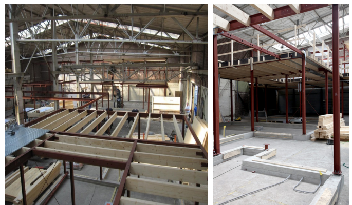
LICHTE CONSTRUCTIES MET SPREIDBALKJES OP BESTAANDE VLOER
