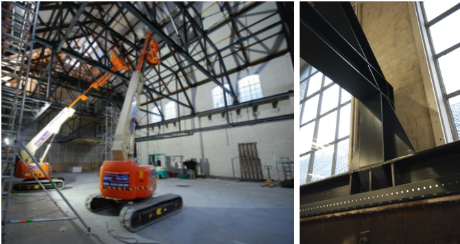
NIEUWE STAALCONSTRUCTIE OP BESTAANDE KRAANBAAN
